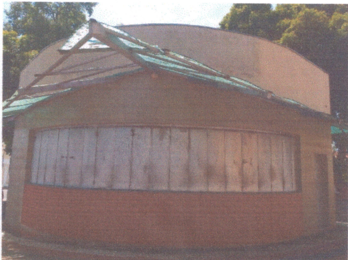
Foto 15 – Telhas quebradas
