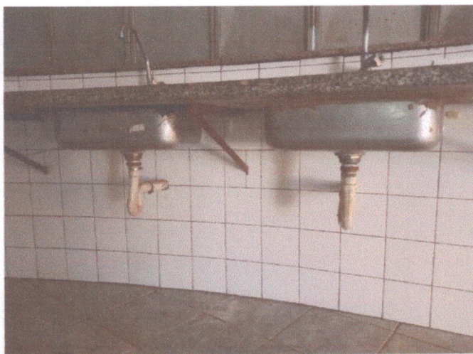
Foto 5 – Sifões deteriorados
