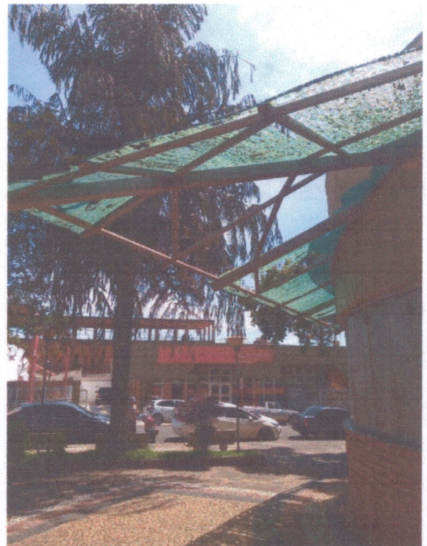
Foto 14 – Telhas quebradas
